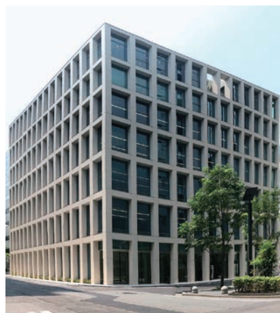
新「全国信用組合会館」2019年7月31日竣工
