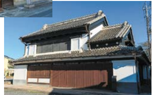
米穀店の見世蔵を改装した 農産物直売所「あくとの里」
