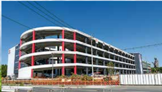
建設が進む大型物流施設
